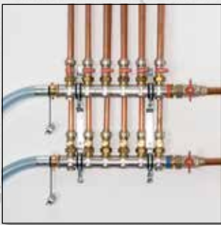
Spülen von Radiatoren- und Flächenheizsystemen (S/SL/SLW)
