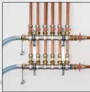
Spülen von Radiatoren- und Flächenheizsystemen (S/SL/SLW)
